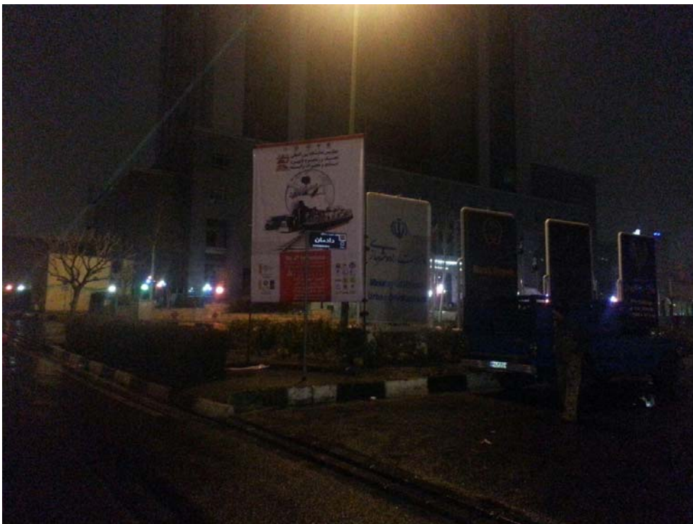
ساختمان راه آهن
